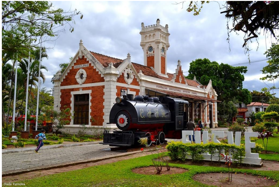
Figura 9 - Antiga Estação da cidade de Vassouras-RJ.
