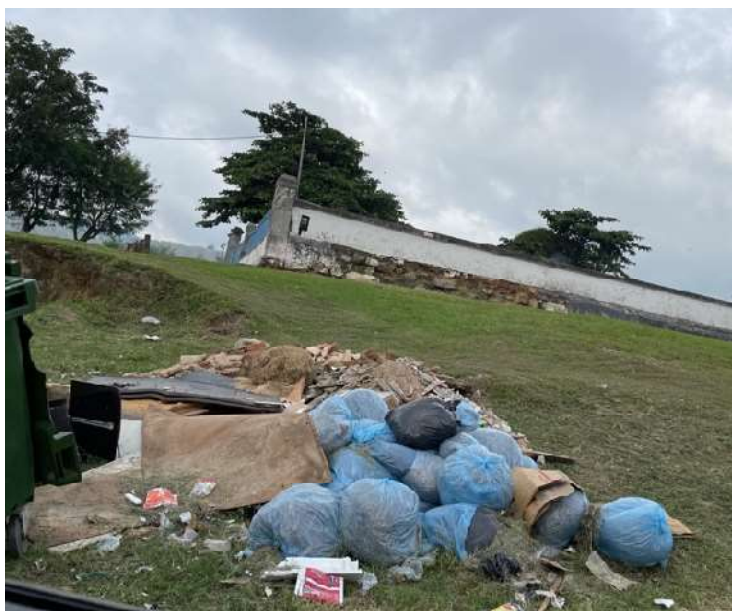
Figura 14 - Depósito inadequado de Resíduos da Construção Civil em um terreno baldio, com contaminação de Resíduos Sólidos Urbanos, observado no bairro Campo Limpo, Vassouras, RJ.
