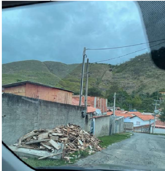
Figura 10 - Depósito inadequado de Resíduo da Construção Civil, obstruindo completamente a calçada, no Bairro Mancusi, Vassouras, RJ.
