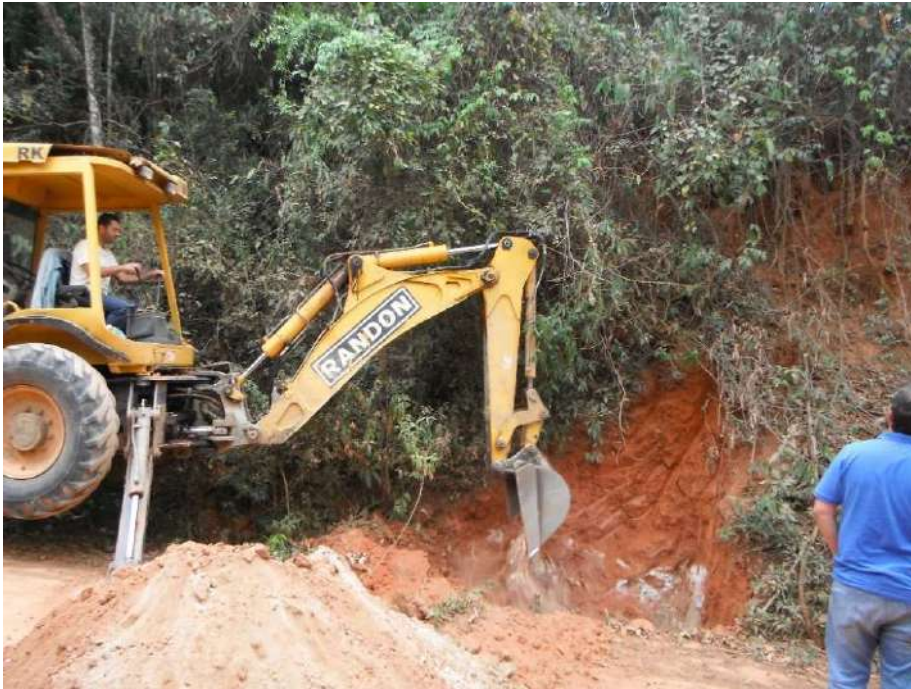
Figura 20 – Construção da Caixa Seca 18, de coordenadas S 22°27'14,31" e W 43°23'13,86"
