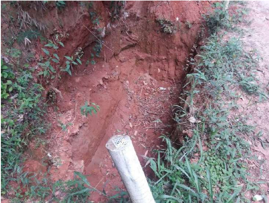
Figura 21 – Foto de Caixa Seca em pleno funcionamento
