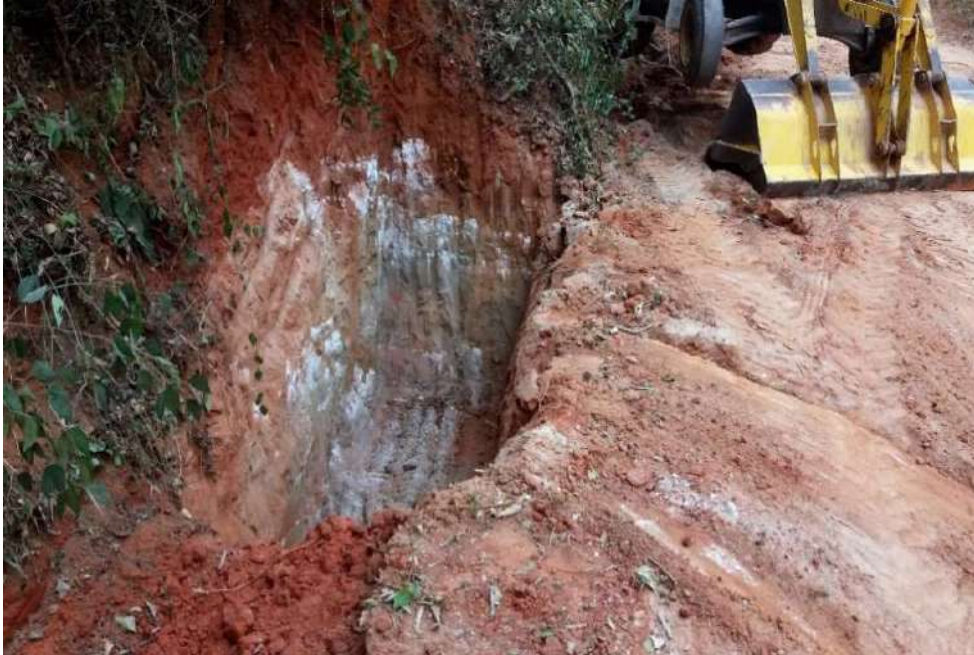
Figura 3 - Caixa seca construída no projeto piloto da APA-Palmares- Paty do Alferes-RJ-2017/18.
