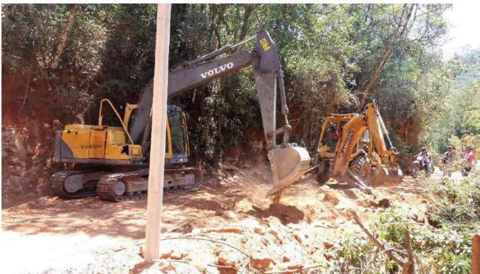
Figura 19 – Início da construção da Barraginha
