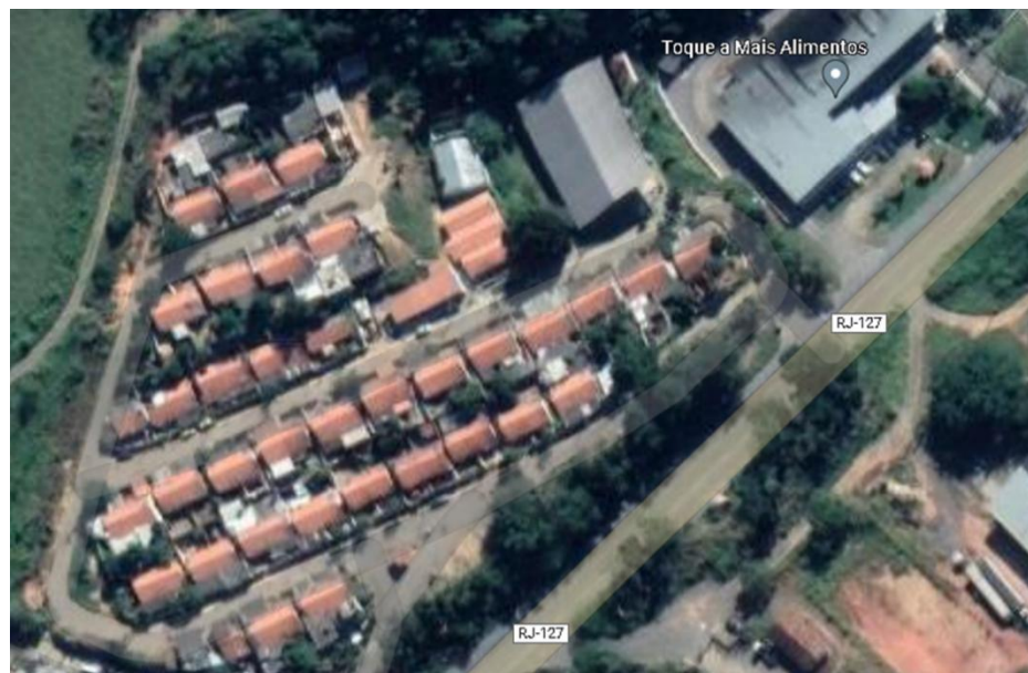
Figura 6. Vista aérea do Conjunto Habitacional da Toca dos Leões - Vassouras/RJ.
